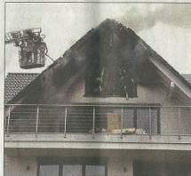
Der Giebel des relativ neuen Hauses wurde vom Brand schwer beschädigt.
